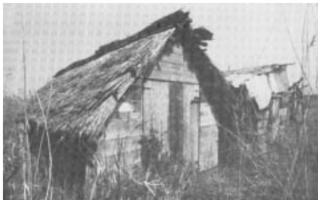
Nel basso ravennate si trova la capanna col muro di terra ricoperta di canna o di paglia.
